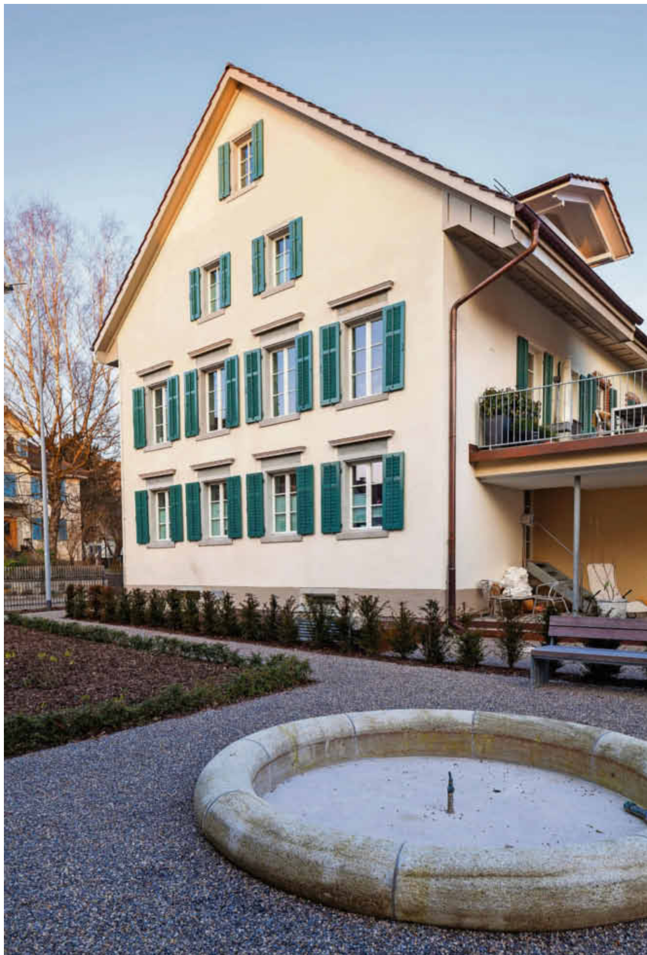
Dieser bedeutende Zeuge der Ustermer Bau- und Wohnkultur um 1850 wurde fachgerecht restauriert. Bilder: Silvano Pedrett
